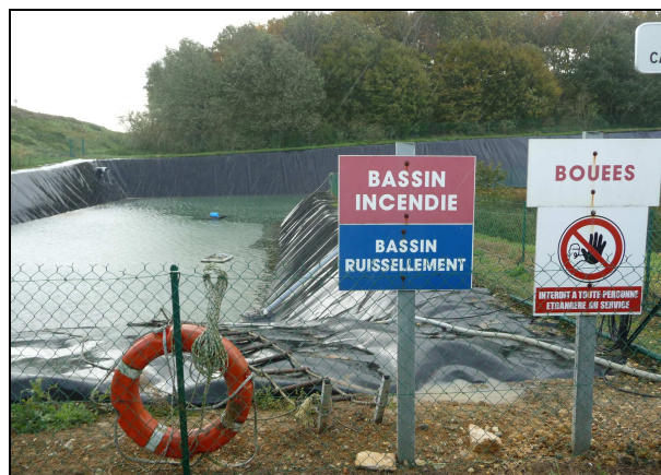
Photo 11 : Exemple des équipements et affichages au niveau des bassins sur l'ISDND
